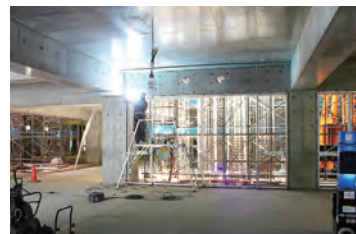
1階の内装。大教室や学生用の ロッカーを整備予定。
