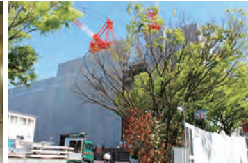
自然環境に配慮した工事現場。
