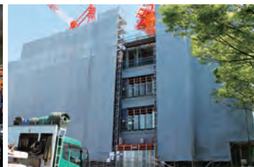
メインストリートから見た 新研究・教室棟。 5階の床まで工事が進められている。
